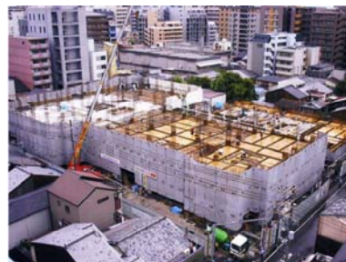
工事現場の油小路からの俯瞰
